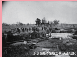
水道施設の施設工事(大正初期)
