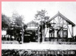
水道施設の施設工事(大正初期)
