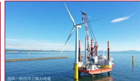
SEP船（自己昇降式作業船） 作業の様子
