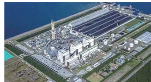
能代火力発電所 全景 スタッフが同乗し構内をご案内
