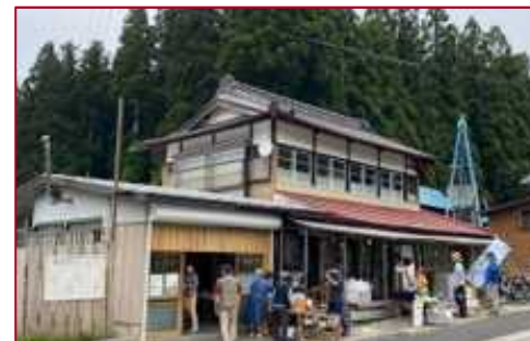
地域住民にも開放。空家となった古民家を改修したAKINOMIYA-BASE
